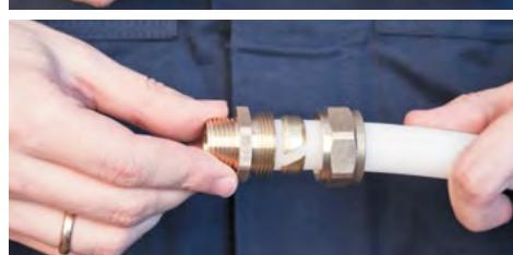
Насадить трубу на штуцер фитинга до упора. Снимать фаску с трубы и проводить какие-либо дополнительные действия не требуется.
