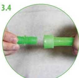
Извлеките инструмент из трубы и немедленно вставьте штуцер фитинга ПЭ-сс «Оптима» в расширенное отверстие трубы, так чтобы гильза плотно, без зазора, уперлась в ограничительные выступы фитинга. Удерживайте фитинг в этом положении несколько секунд, пока труба под действием усадочной гильзы не сожмется вокруг штуцера фитинга.
